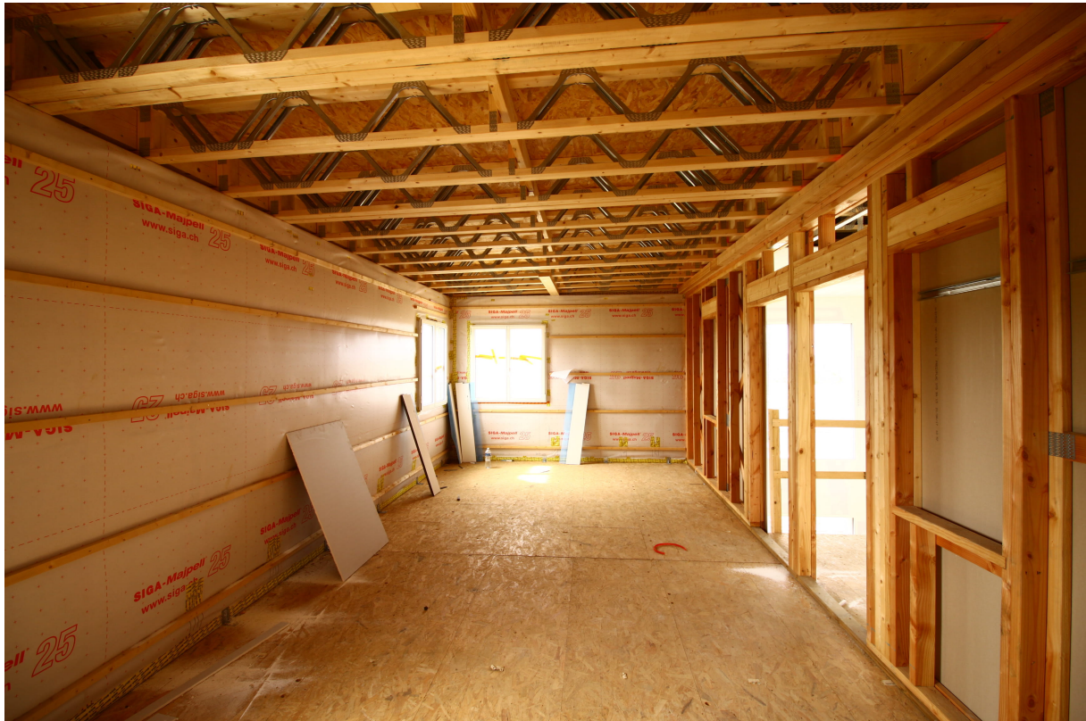
Un chantier de construction Arteck d'une maison à ossature de bois. © Arteck (photo libre de droit)
