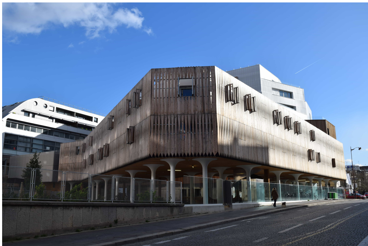
La résidence Simone Veil à Paris, inaugurée en octobre 2018, mêle bois et béton. © David Pauget
